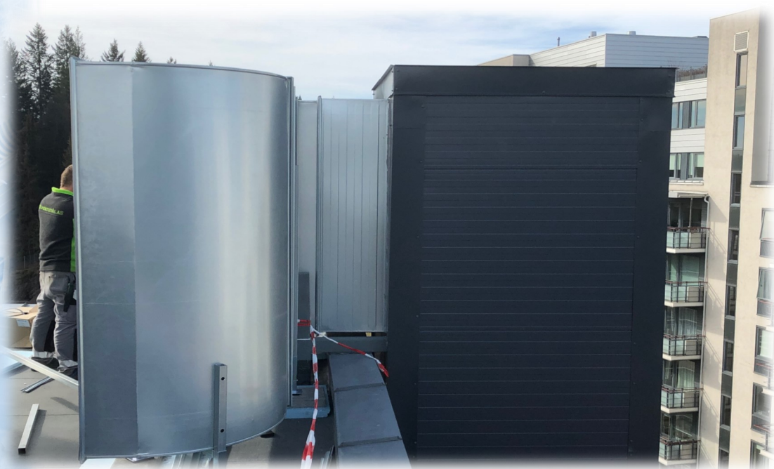
Montasje av utvendig ventilasjons sjakt med PIR panel
